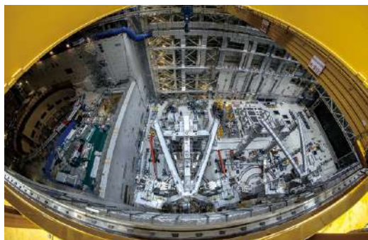
フランスで建設が進むITER（国際熱核融合実験炉） 写真：ITER Organization
